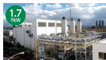
■ 摂津エネルギーセンター
