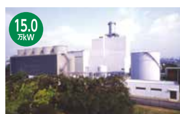
■ 西島エネルギーセンター
