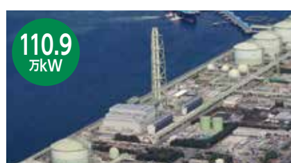
■ 泉北天然ガス発電所
