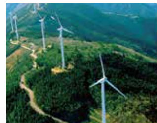
葉山風力発電所 (2万kW)
